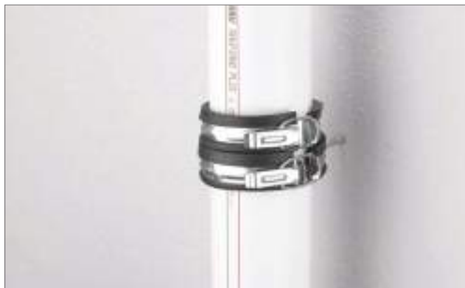
Рис. 8-3 Шумопоглощающий хомут в смонтированном состоянии
